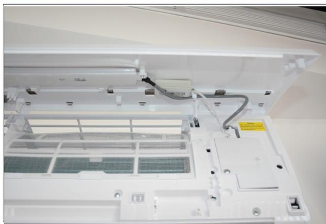
**4** Подключите один конец разъема кабеля контроллера к разъему кабеля управления внутреннего блока, второй конец к контроллеру DW.
